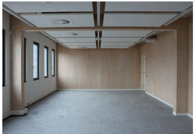
De ruimtes zijn goed indeelbaar, hout kon bijna overal in het zicht blijven. Verwarming en luchtverversing zitten in het plafond.
