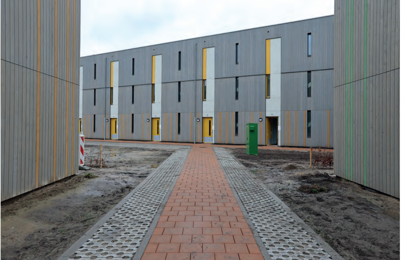
Gevelopeningen aan de buitenzijde van de hofjes zijn grotendeels gesloten, tegen het 'flikkeren' van de wieden en geluidsoverlast van de omliggende bedrijven.
