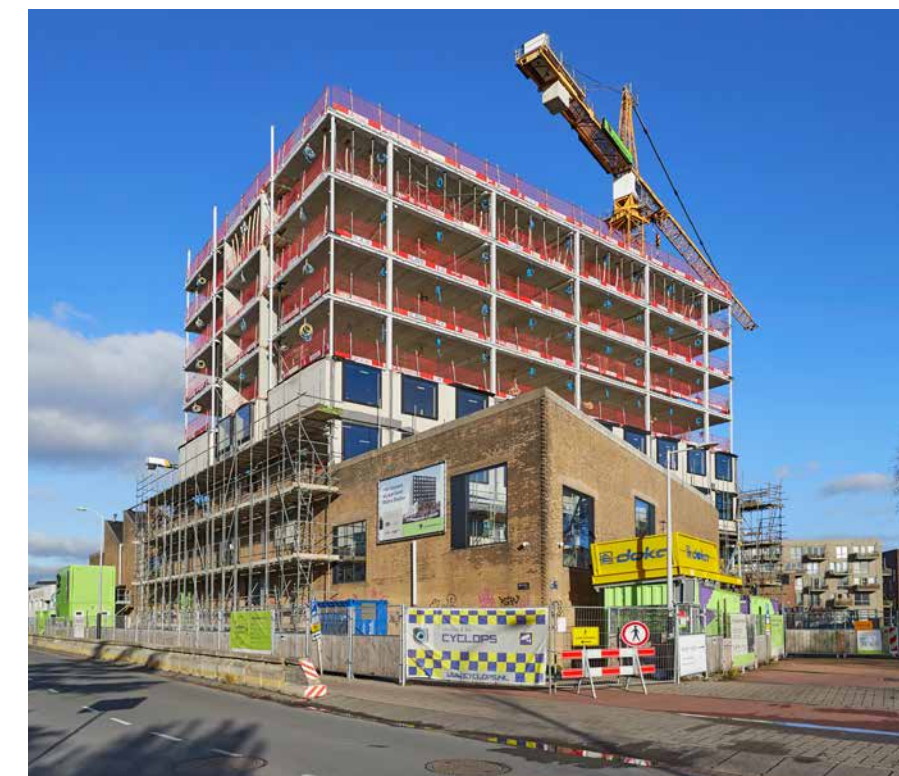
De nieuwe hoofdconstructie van de hoteltoeren bestaat uit twee betonnen kernen voor verticaal transport en kanaalplaatvloeren, in combinatie met leidingplaatvloeren voor de inbouwinstallaties en stalen liggers. (Beeld: Bert Rietberg voor J.P. van Eesteren)
