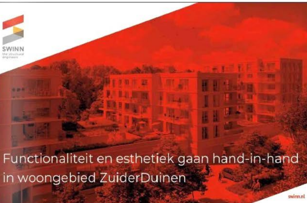
Ondanks hun geringe dikte hebben de balkons een uitkraging van maar liefst 3 meter.
