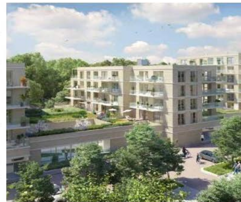
Ondanks hun geringe dikte hebben de balkons een uitkraging van maar liefst 3 meter.
