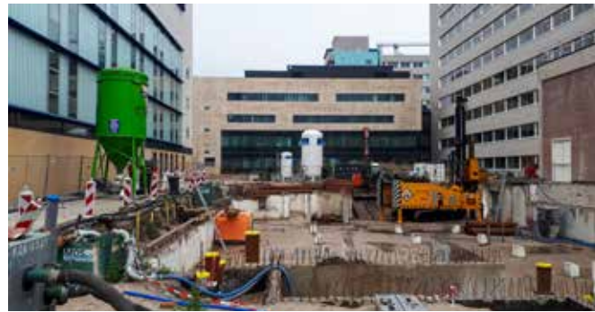
Werkzaamheden aan het apotheekgebouw bij het Antoni van Leeuwenhoek ziekenhuis.
