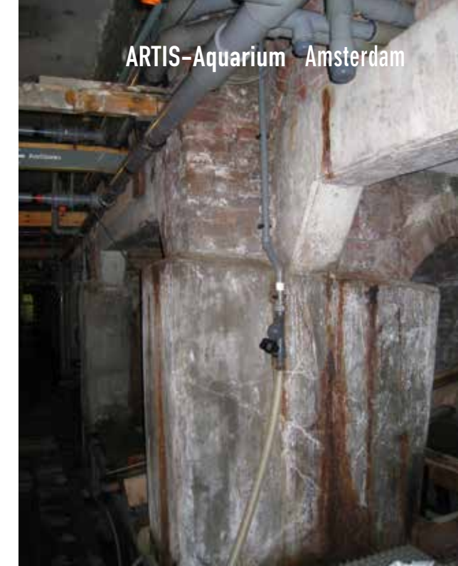
Aantasting veroorzaakt door optrekkend vocht en zoutkristallisaties.
